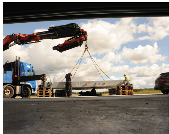
Helikopterens trolley bliver løftet på plads i Billund Foto: Henrik Brøns
